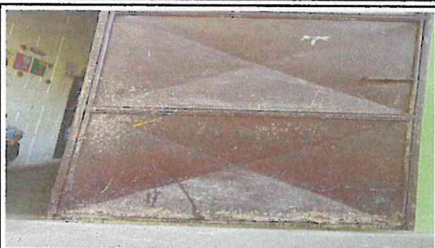
Foto 1: Sustrucción de de puerta metal de metal en dos salones de clase y sanitario
