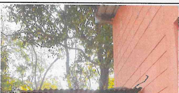
Foto 5: Implementación de tinaco de 1,100 litros
